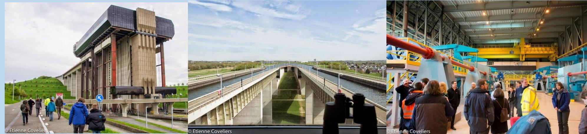
L'ascenseur se compose de deux bacs qui fonctionnent sur un système de contrepoids. Chaque bac a une dimension de 118.60x16.50x8.00 m et pèse 2600 tonnes à vide et 5550 tonnes pour une hauteur d'eau normale de 3.75 m.
