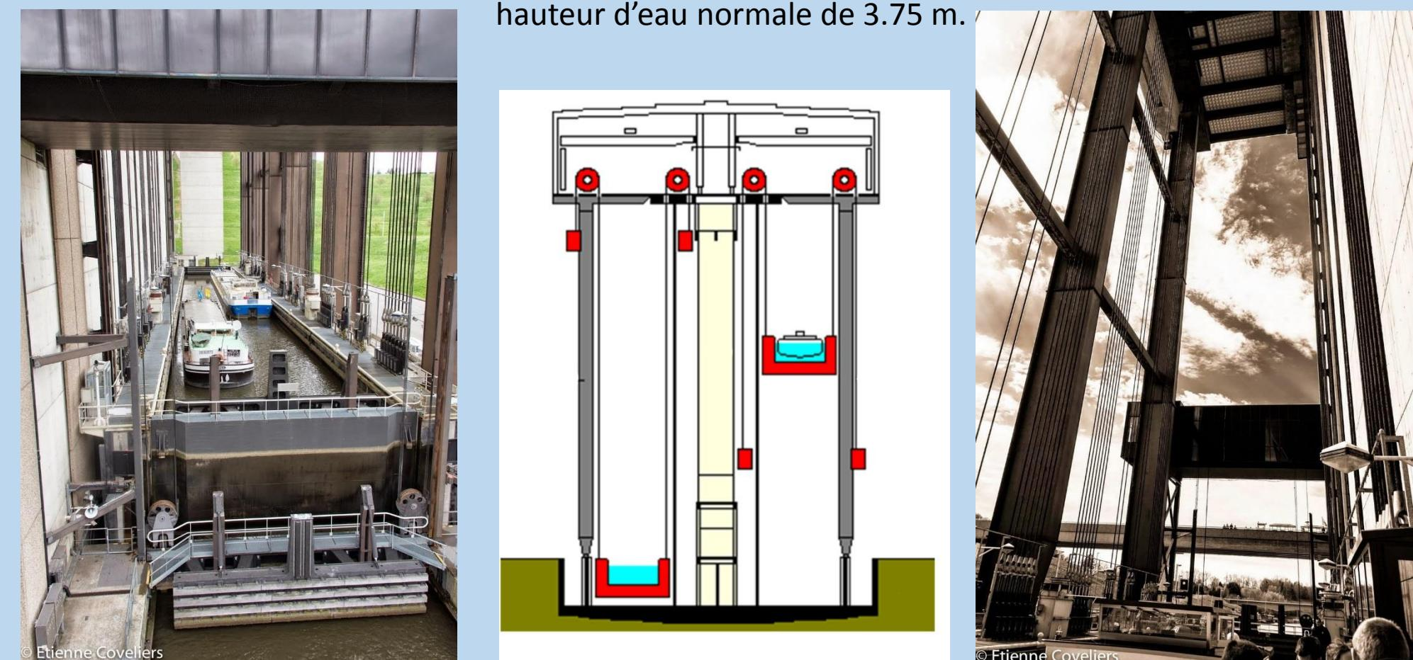
Le déplacement vertical permet à un bateau d'une dimension maximale de 112 m de long et 12 m de large, soit une barge de 2000 tonnes et son pousseur, de passer du bief amont (D, niv. 121.15 m) au bief aval (E, niv. 48.00 m soit 73.15 m plus bas) en 40 minutes.
