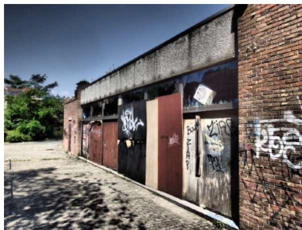
Piscine de Braine-l'Alleud, face sud, côté cafétéria. Un peu Far West dans le style Lucky Luke contre les Dalton...
