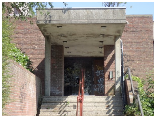
Escalier d'accès à la piscine de Braine-l'Alleud.
