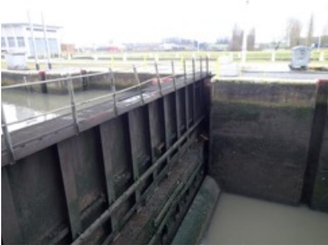
*Figure 3 : Porte en position fermée (remarquez le coup dans le garde-corps, dû à un batelier trop pressé)*
