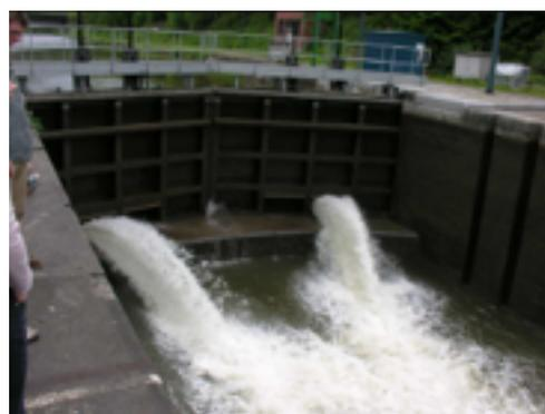
*Figure 2 : Porte busquée avec vannes intégrées à la porte pour le remplissage du sas*
