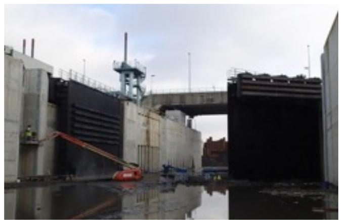
*Figure 10 : les deux vantaux de la porte busquée aval*
