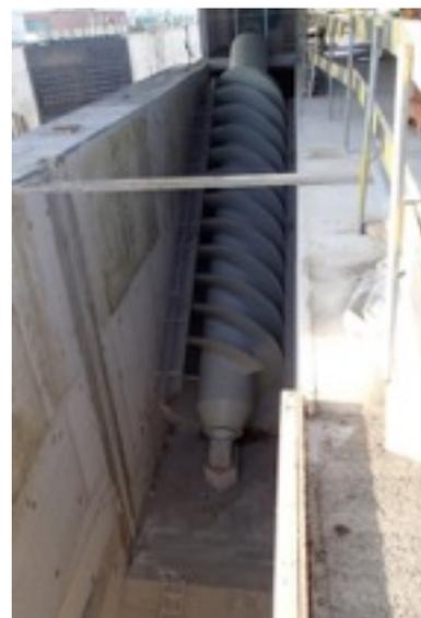
*Figure 12 : Vis d'Archimède qui produira l'électricité du site. Cette vis est fish-friendly.*
