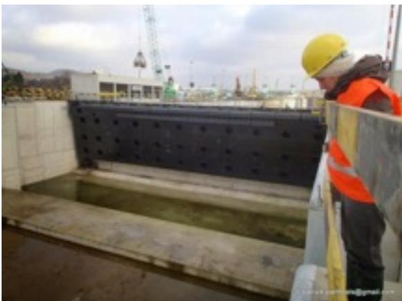
*Figure 9 : la porte clapet amont*
