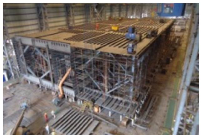
*Figure 6 : Porte de l'écluse d'Anvers, en construction à Shanghai (elle est couchée... et oui, cette porte fait 8m d'épaisseur)*
